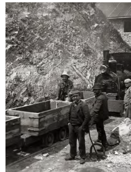
Beim Bau des Albula I wurde das Ausbruchmaterial auf kleinen Loren aus dem Tunnel gefahren.
