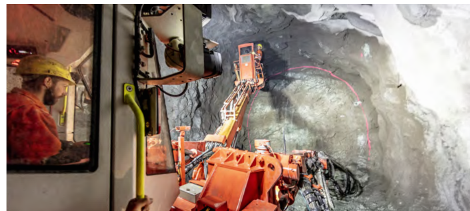
Albula II: Eine von zwei Jumbo-Bohrmaschinen im Einsatz.
